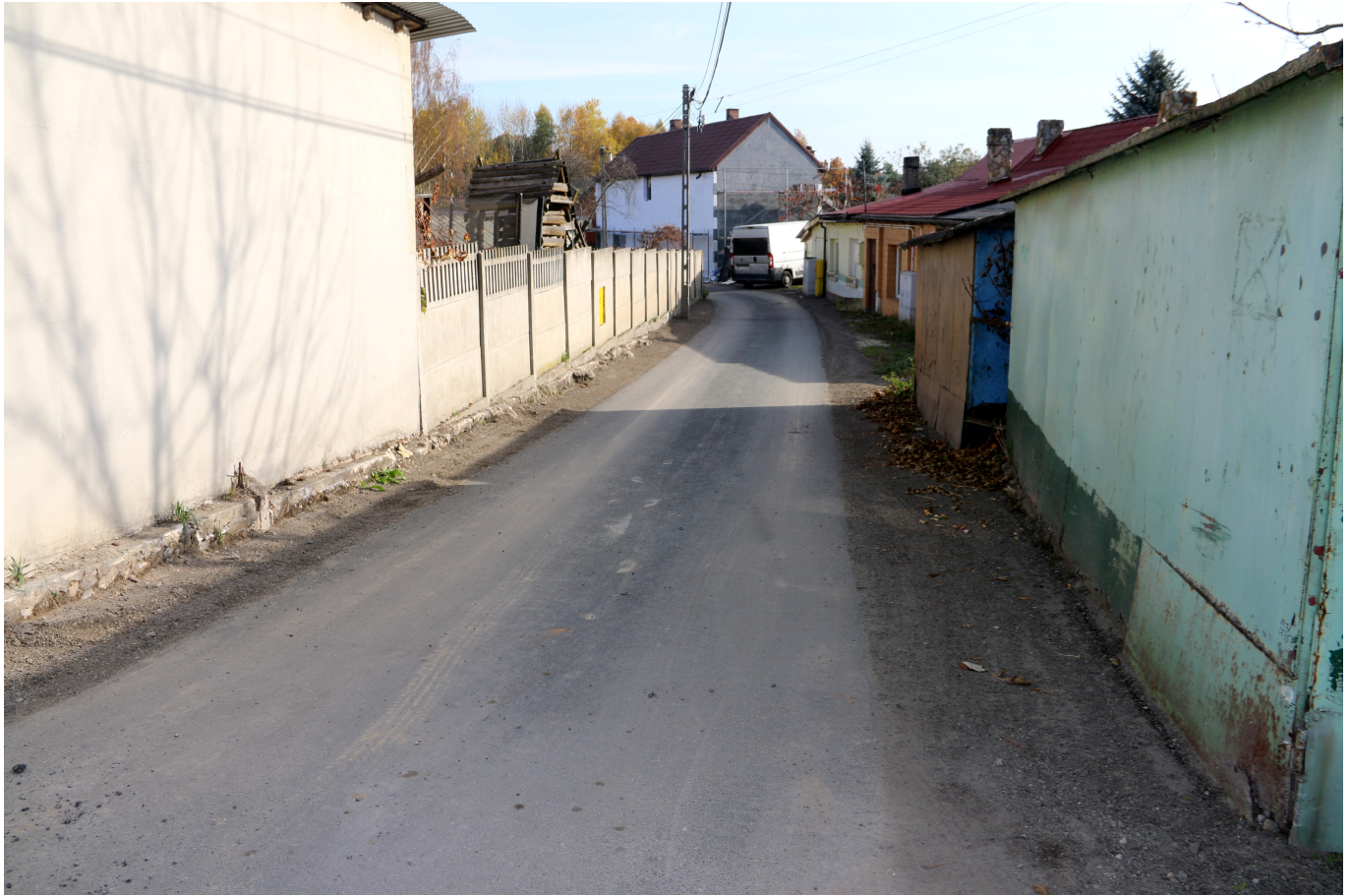
Ulica Owocowa z nową, asfaltową nawierzchnią.
