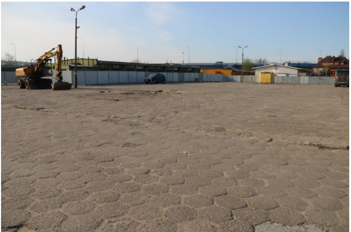
Tak przed rozpoczęciem inwestycji wyglądał plac handlowy przy ul. Targowej.
