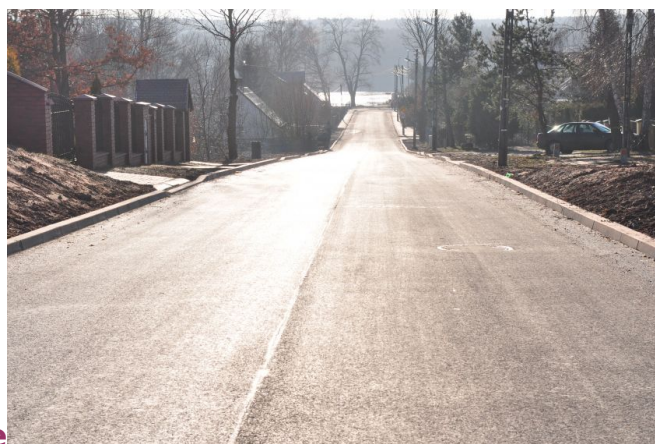
ul. Żytnia po przebudowie
